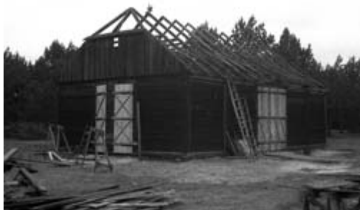
Budowa stodoły z Karczmiska
