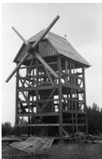
Budowa wiatraka z Rzędzian
